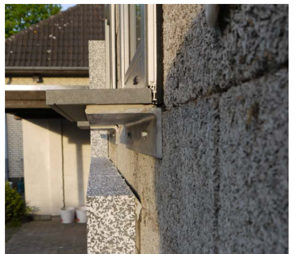
Dämmung der Fassade © privat
