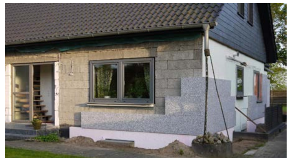
Dämmung der Fassade © privat
