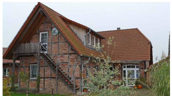
Das fertig sanierte Haus
