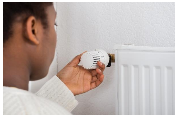
Durch die Erstellung von Energiesparregeln konnte der Heizverbrauch der Nibelungen-Realschule deutlich gesenkt werden. (© shutterstock_Andrey_Popov)
