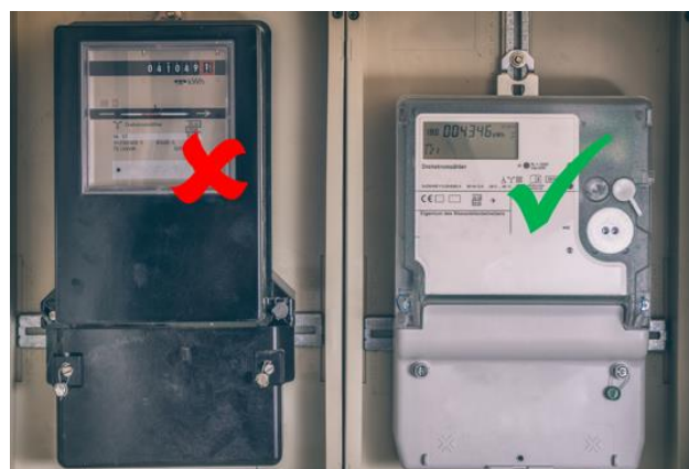
Abbildung 4: Ferraris-Zähler (links), Zweirichtungszähler (rechts).
