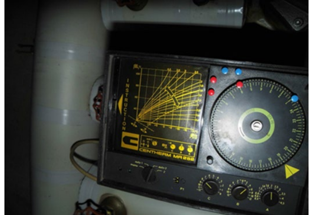
Foto der Regelung einer Heizungsanlage (2)
