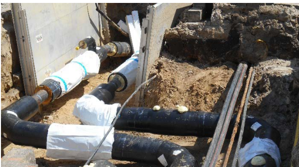
Nutzung industrieller Abwärme für Wärmeversorgung eines Wohngebietes in Venne ©Dawin Meckel
