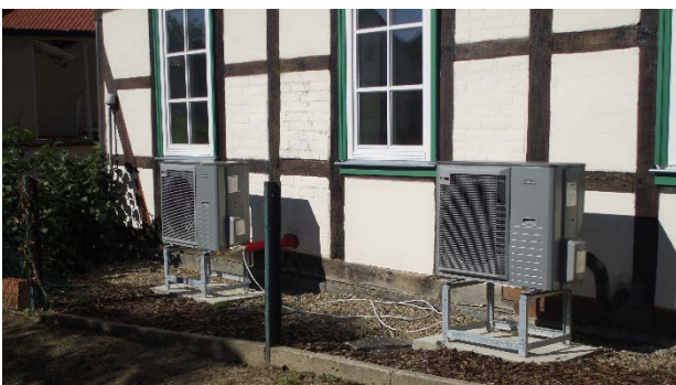
Wärmepumpe zur dezentralen Versorgung © Energieberatung Thomas
