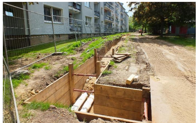
Leitungsbau im Quartier Hildesheim-Drispstedt © gbg Hildesheim
