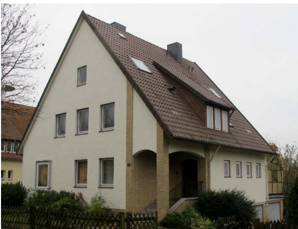
Außenansicht vor der Sanierung
