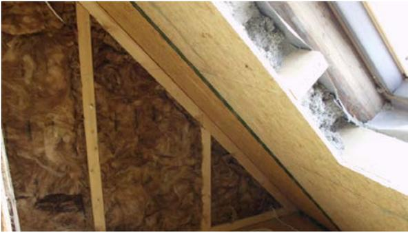
Dachausbau mit Einblasdämmung, © EBT
