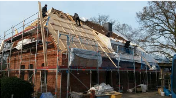
Instandsetzung des Dachs und Dämmung © privat
