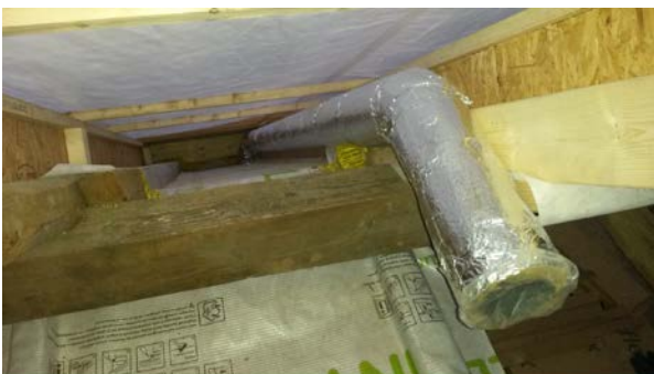
Dachausbau mit Lüftungsanlage, © privat
