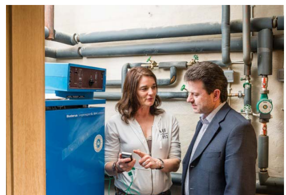
Bestandsaufnahme: Eine qualifizierte Energieberatung bietet einen Überblick über den Zustand des Gebäudes und die Handlungsmöglichkeiten. Foto: Stefan Koch
