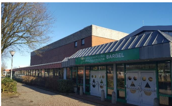
In die Jahre gekommen: Die Dreifeldturnhalle in Barßel. Für sie wird mit Hilfe von Fördermitteln ein Sanierungsfahrplan erstellt. Foto: Markus Wiechmann
