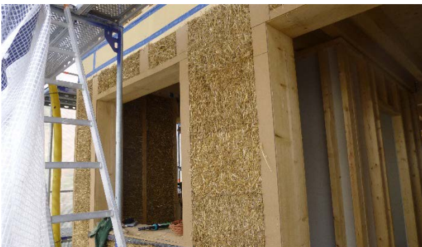
Die Strohgedämmte Holzkonstruktion © Stephan Seeger
