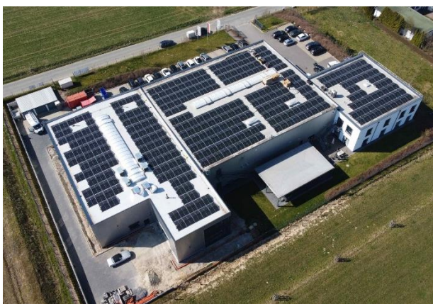
Die neue Anlage auf dem Unternehmensdach sorgt für erneuerbaren Solarstrom © C. Mücke
