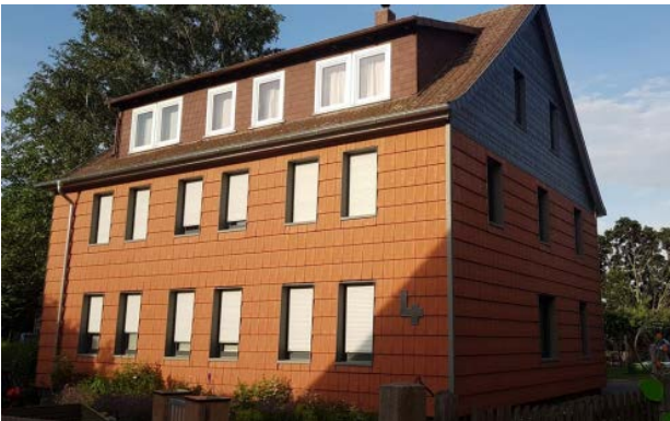
Zustand nach Sanierung © Edlmann
