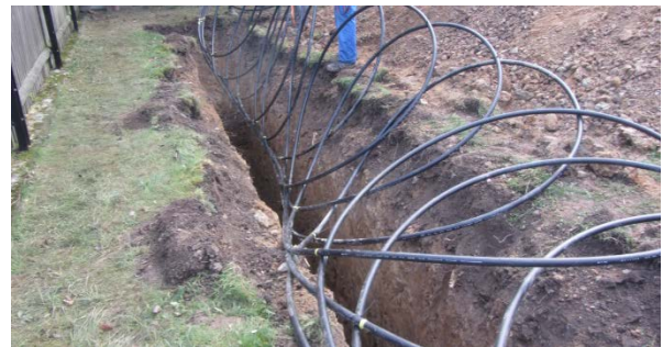
Senkrechte Verlegung der Grabenkollektoren © Edelmann
