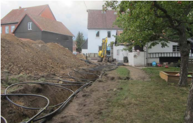
Am Rande des Grundstücks wurden die Gräben gezogen © Edelmann
