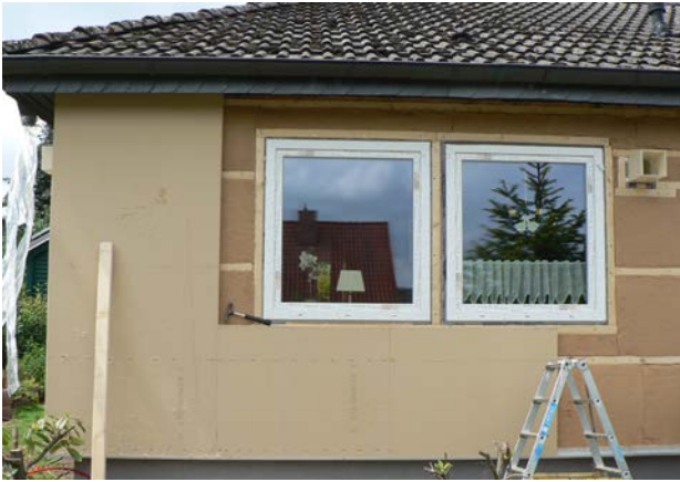
Aufbau der Fassade nach Sanierung
