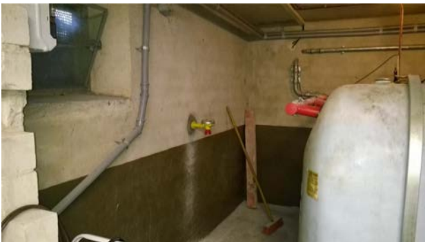
Die alte Öl-Heizung muss weichen und wird durch eine Gas-Therme ersetzt
