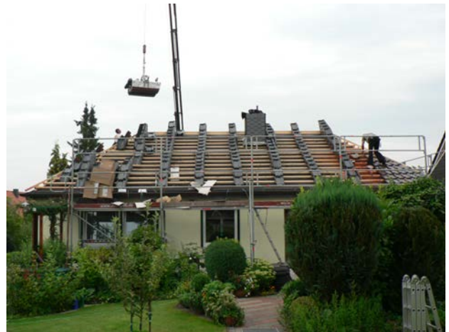
Die Dachisolierung wird erneuert
