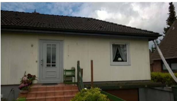
Vor der Fassadensanierung
