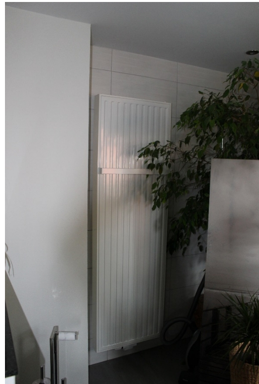
Einbau größerer Heizkörper, hier Bad im Erdgeschoss
