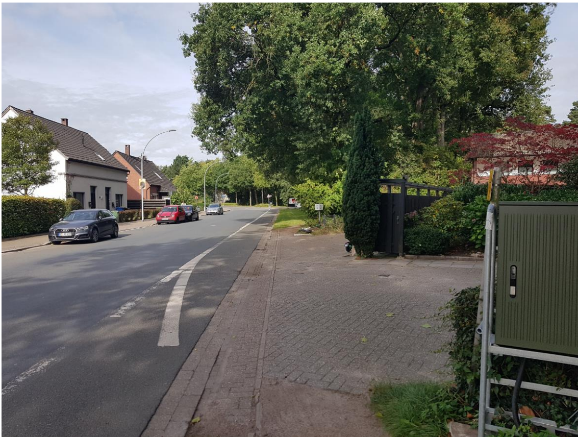
Abbildung 15: Engstelle am Übergang zwischen den Grünanlagen auf Höhe der Hausnummer 30
