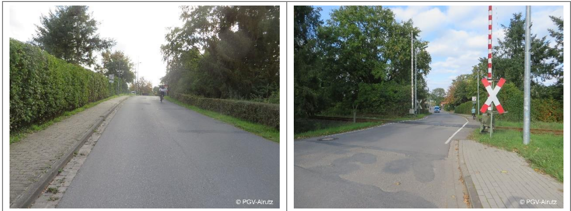
Abb. 3: Neue Straße zwischen Rieselweg und Bahnübergang
