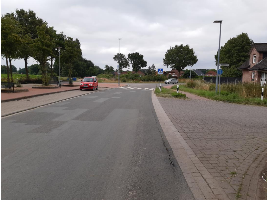
Bild 3: Bürgerschützenstraße mit Parkstraßen Nordseite, gemeinsamen Geh-/ Radweg Südseite und Fußgängerüberweg
