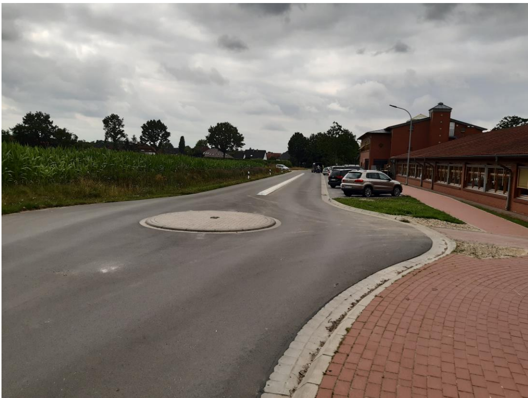
Bild 4: Am Gültum mit Gehweg und Parkstreifen auf der Westseite, Minikreisverkehr zum Wenden sowie baulich erhöhtem Mittelstreifen
