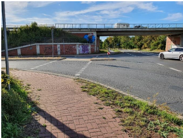
Abb. 11: Radwegfurt an der Einmündung der Werner-von-Siemens-Straße, im Hintergrund die Ortsumgehung B244 (Blickrichtung stadtauswärts)
