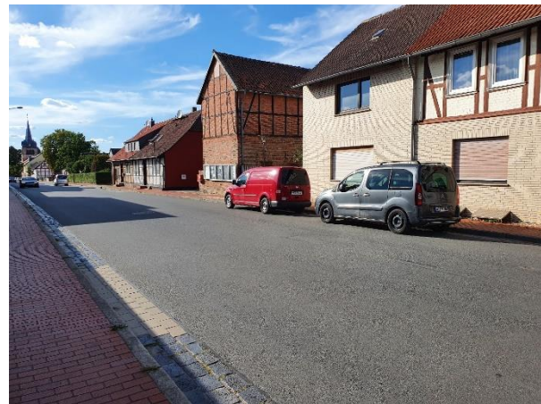
Abb. 5: Aufgeweitete Fahrbahn mit parkenden Fahrzeugen im mittleren Abschnitt der OD Emmerstedt
