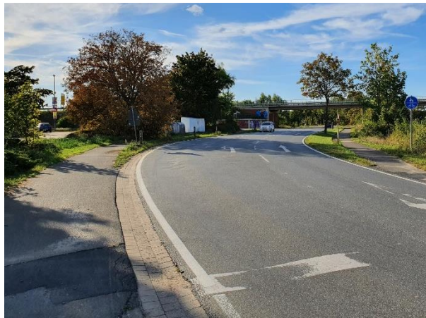
Abb. 12: Beginn des nördlichen und südlichen Radweges Richtung Emmerstedt unmittelbar hinter dem Bahnübergang (Blickrichtung stadtauswärts)
