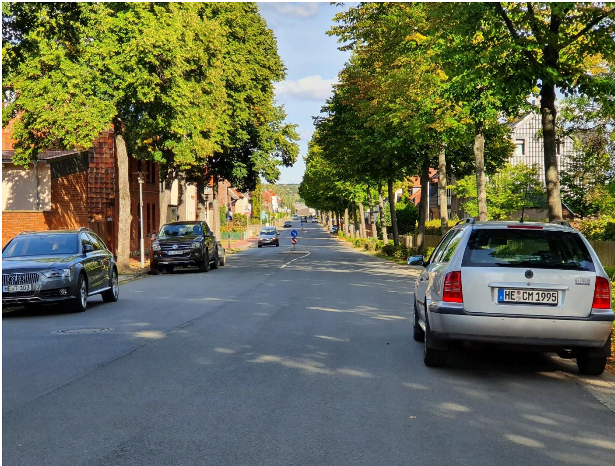
Abb. 8: Östlicher Abschnitt der OD Emmerstedt mit Alleencharakter, Querungshilfen und Fahrbahnparken
