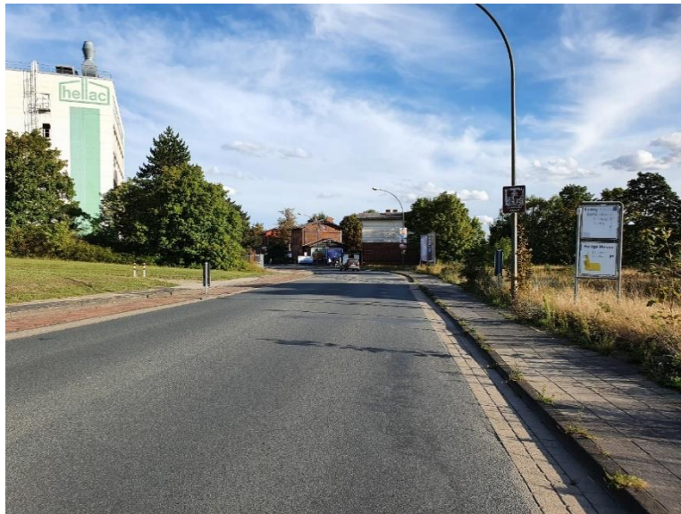
Abb. 15: Emmerstedter Straße vor dem ehem. hellac-Gebäude (Blickrichtung stadteinwärts)
