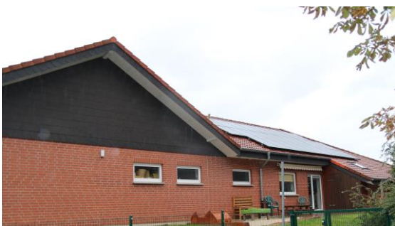
Im Anschluss an eine Impulsberatung Solar wurde der Kindergarten Grupenhagen mit einer PV-Anlage ausgestattet. ©Klimaschutzagentur Weserbergland
