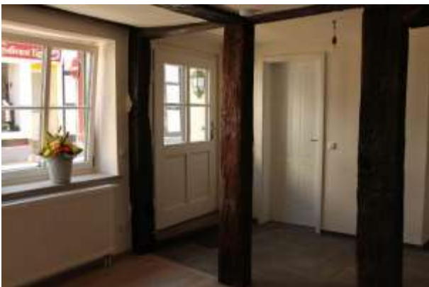
Ein Austausch schadhafter Teile des Fachwerks sorgt für Stabilität und Charme © Stephan Kahlisch
