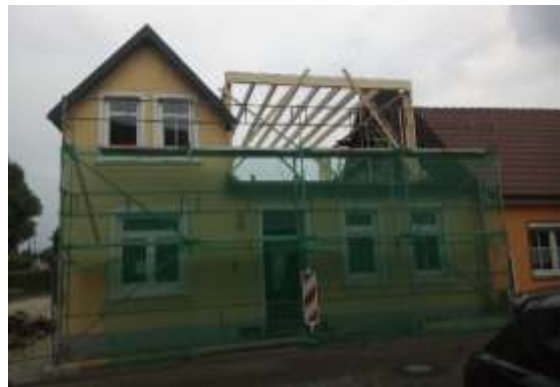
Die Livingbox wird in das ausgeschnittene Satteldach integriert © Ralph Thater
