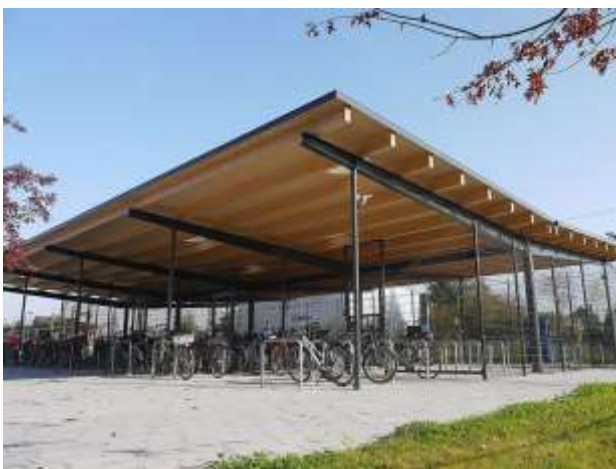
Die neue Fahrradgarage am Bahnhof © Region Hannover
