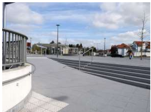
Die barrierefreie Unterführung sorgt für eine verbesserte Mobilität im Bahnhofsumfeld © Region Hannover
