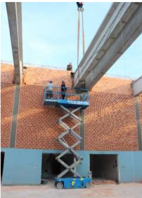
Der Austausch der Dachkonstruktion war für die Sicherstellung der Stabilität des Gebäudes essentiell © M. Wiechmann
