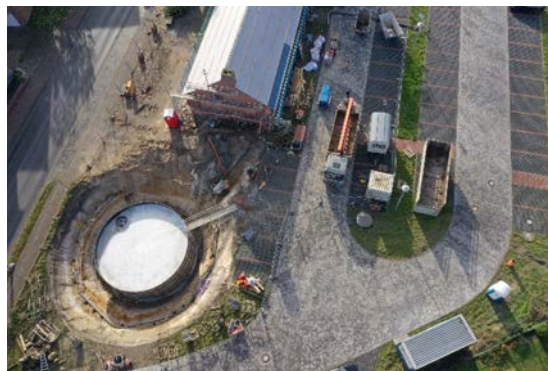
Eisspeicherbau und Solarzaun in der Gemeinde Wahrenholz © Heinrich Bente
