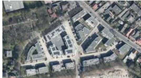
Neubaugebiet mit Mehrfamilienhäusern im KfW.Effizienzhausstandard 40 mit flächendeckend PV © Stadt Oldenburg
